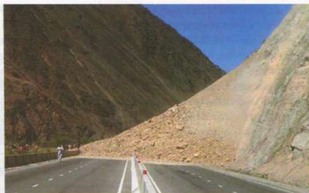
Рис. 1. Оползень на дороге «Бишкек – Балыкчи» (Кыргызстан).
