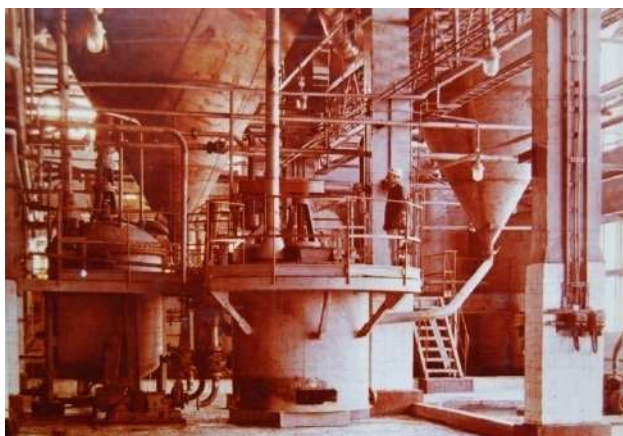
Рис. 3. Реэкстракционная колонна для получения солей АУТК
