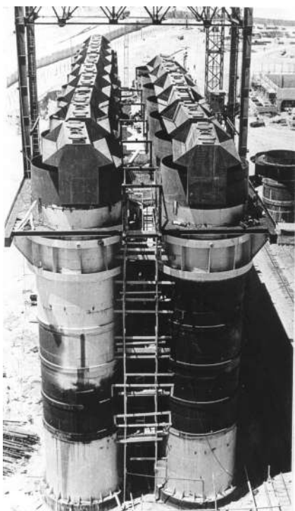
Рис. 4. Монтаж пачуков сорбционного выщелачивания
