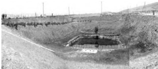
Рис. 4. Вид нижнего водоема (дренаж водоема).
