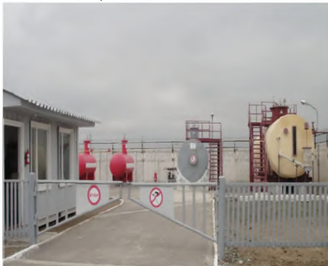
Биогазовая установка птицефермы на 200 м 3 /сутки.
