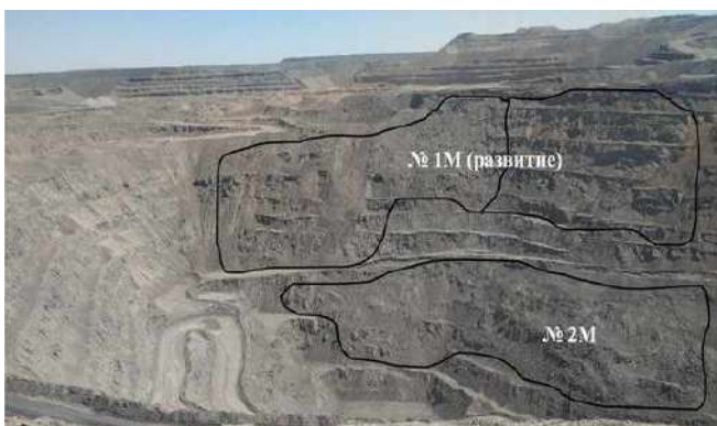
Рис. 3. Деформации на южном борту Мютенбая
