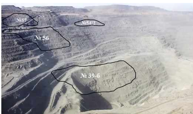
Рис. 2. Деформации на северо-западном борту Мурунтау
