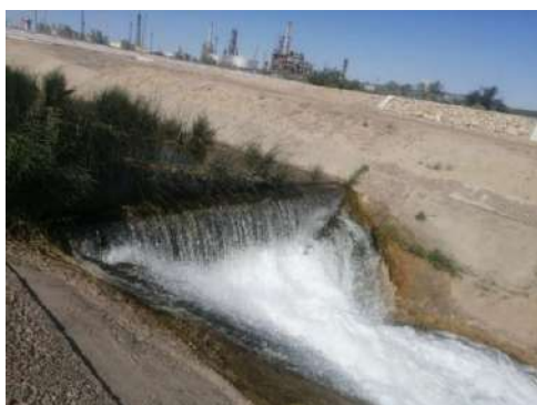
3-rasm. Mikro gidroelektr stansiyasi o'rnatiladigan suv oqimlari joylashgan hudud
