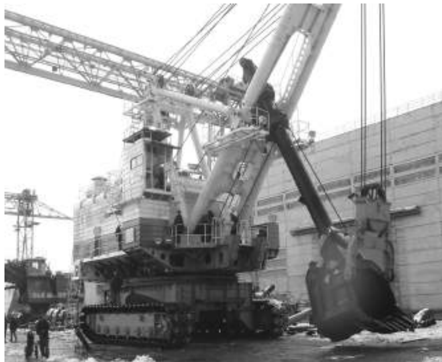
Рис. 1. Замена рабочего оборудования ЭКГ
