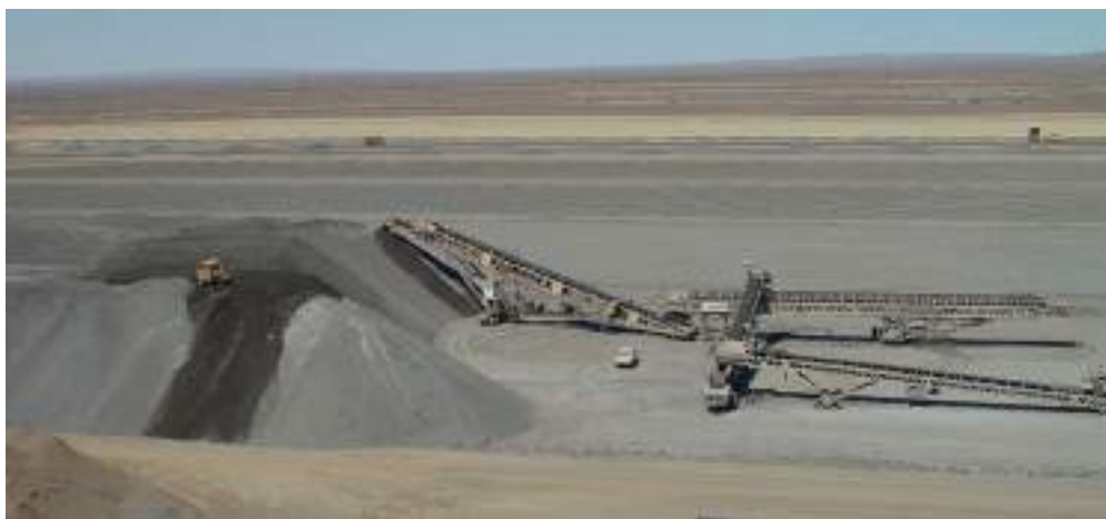
Рис. 3. Укладка измельчённой и агломерированной руды на подушку выщелачивания
