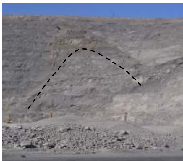
Рис. 1. Деформация на карьере Мурунтау: --- контур деформации
