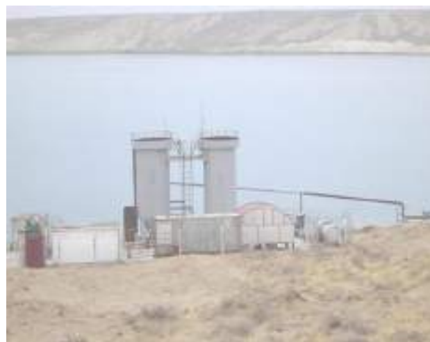
Рис. 1. Локально-сорбционная установка
