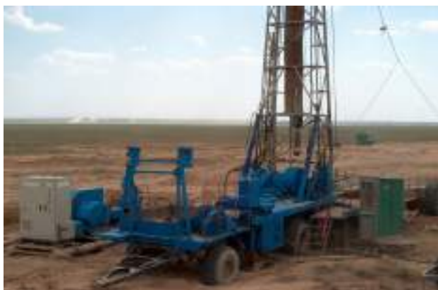
Рис. 2. Первая буровая установка в РУ-5 с электроприводом
