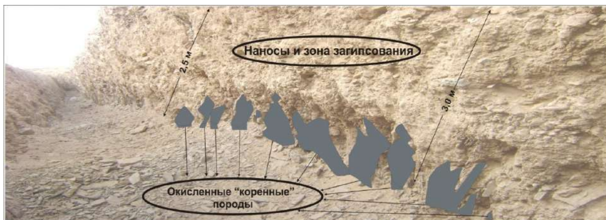
Рис. 1. Фактическая вскрываемость «коренных» пород (траншея)
