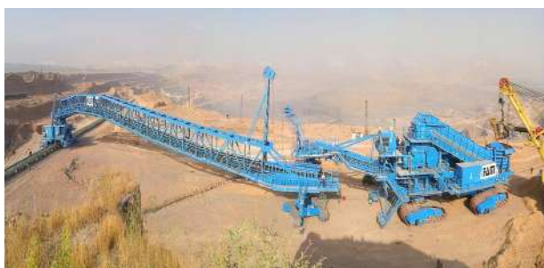
Рис. 2. Комплекс мобильной дробилки с мостовым перегружателем, вид сверху
