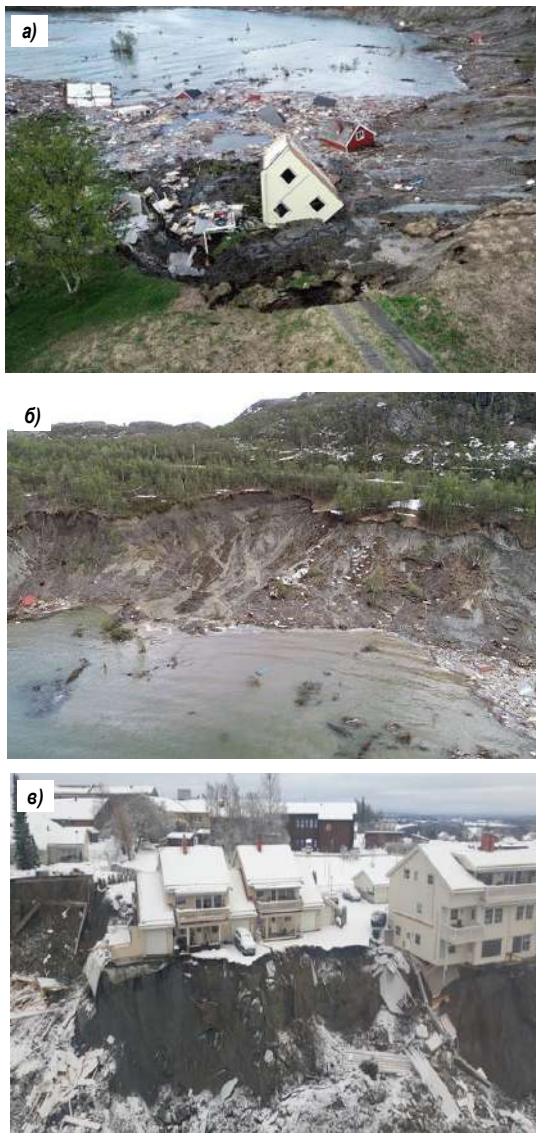
Рис. 10. Быстрые глиняные оползни: а – в Норвегии; б – в Крокнесе недалеко от Алматы; в – в Гердруме (2020 г.) [12]
