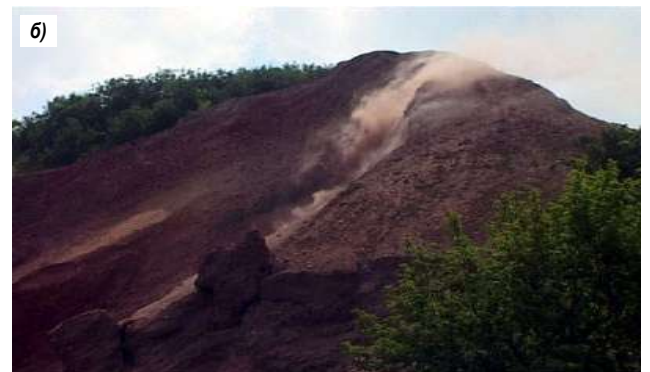
Рис. 5. Террикон шахты 41-бис (а) и обрушение террикона шахты «Центральная» (б) (ДНР, 2011 г.)
