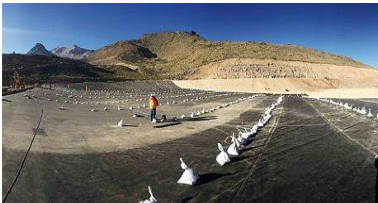
Рис. 4. Фиксация геомембраны балластом
