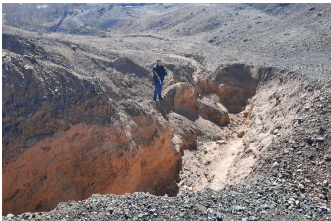
Рис. 2. Разрушение дамбы хвостохранилища и вынос через промоины радиоактивных отходов
