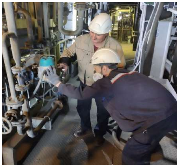
Фото. Обход сотрудников КИП и А по цехам Медеплавильного завода
