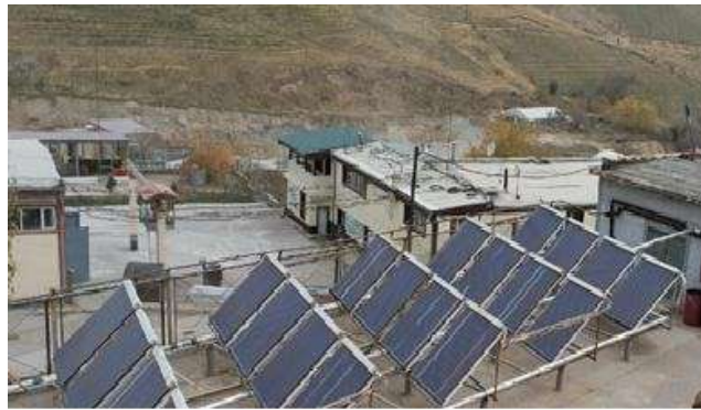
Фото. «Гелиоустановки для подогрева воды на хозяйственные нужды рудника»
