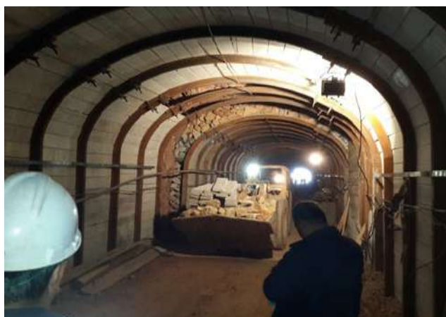
Фото. Производство крепежных работ тоннеля на МОФ-2
