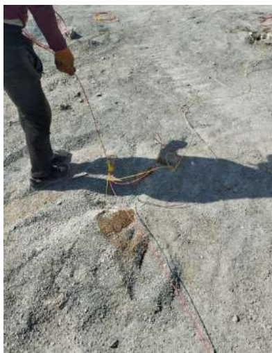
Рис. 3. Соединение скважинных зарядов с использованием Коршун М П-25-4
