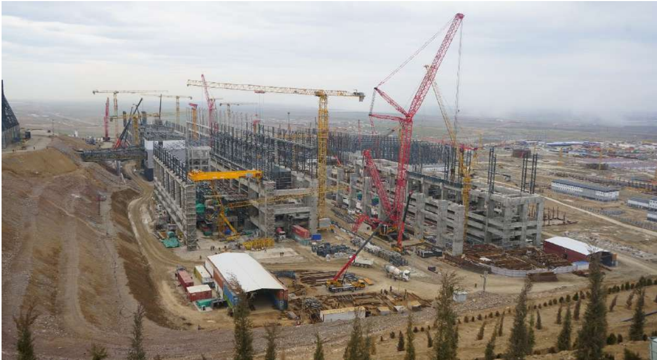
Фото. Строительство комплекса медно-обогатительной фабрики № 3
