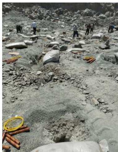
Рис. 2. Патрон аммонит № 6 ЖВ, ИСКРА-С и Игданит в мешках
