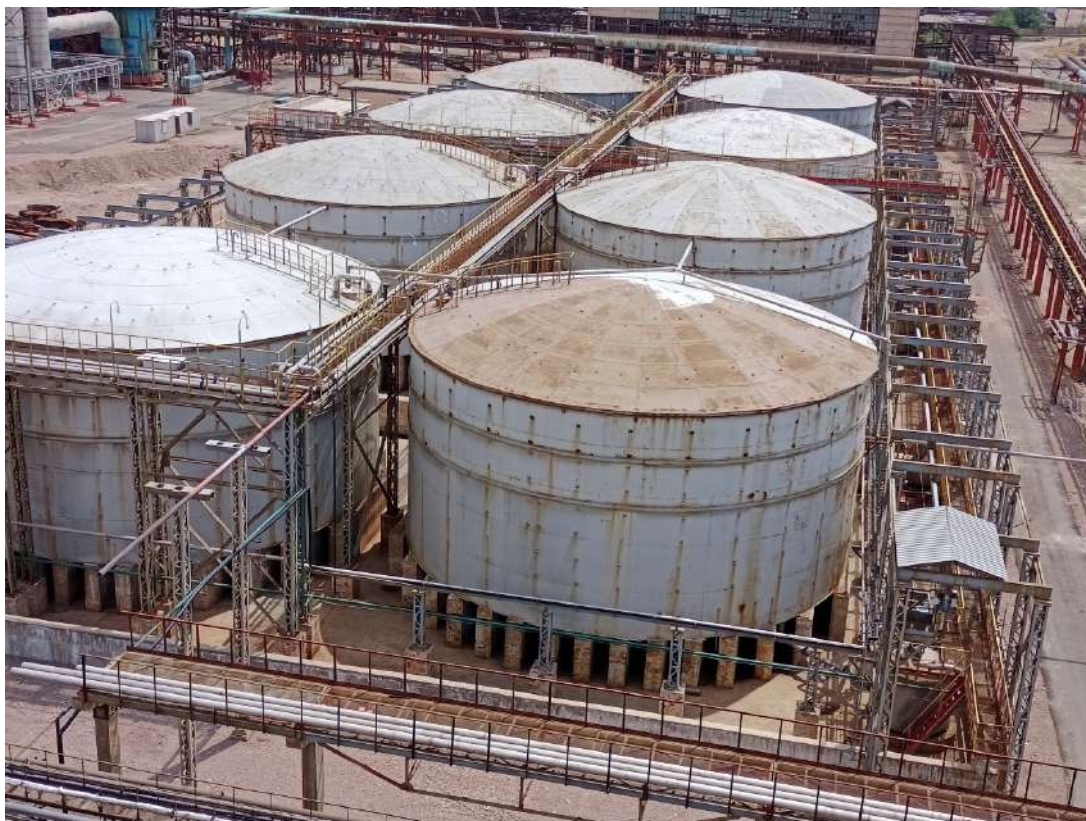
Фото. Ёмкости сернокислотного цеха
