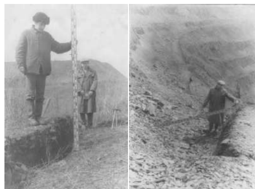
Рис. 3. Карьер «Чегарники». Процесс деформаций прибортового массива при образовании провала
