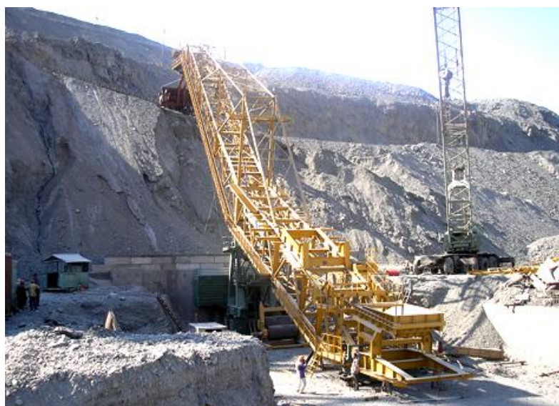
Рис. 5. Перегрузатель КНК-30 на стадии монтажа
