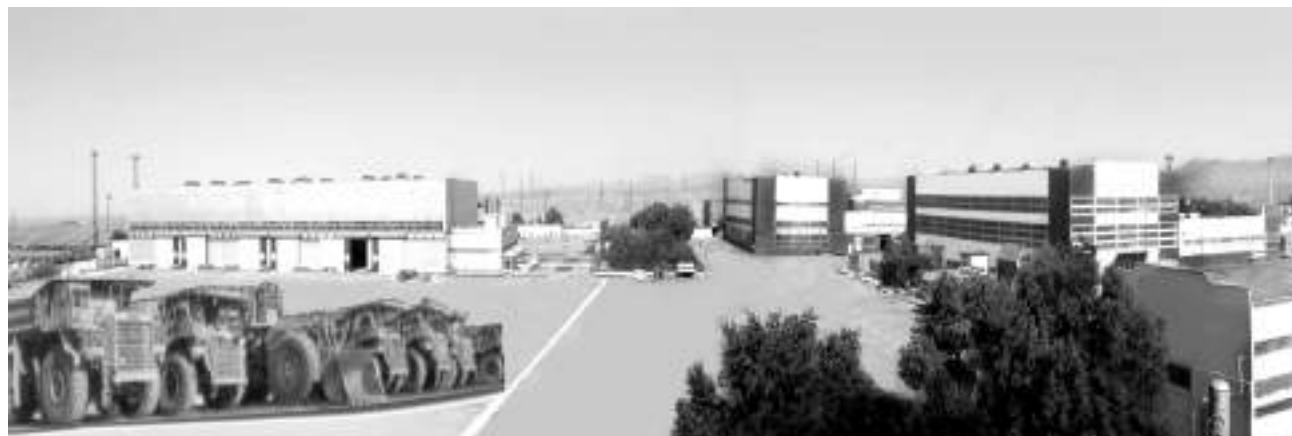
Рис. 1. Ремонтная база УАТ
