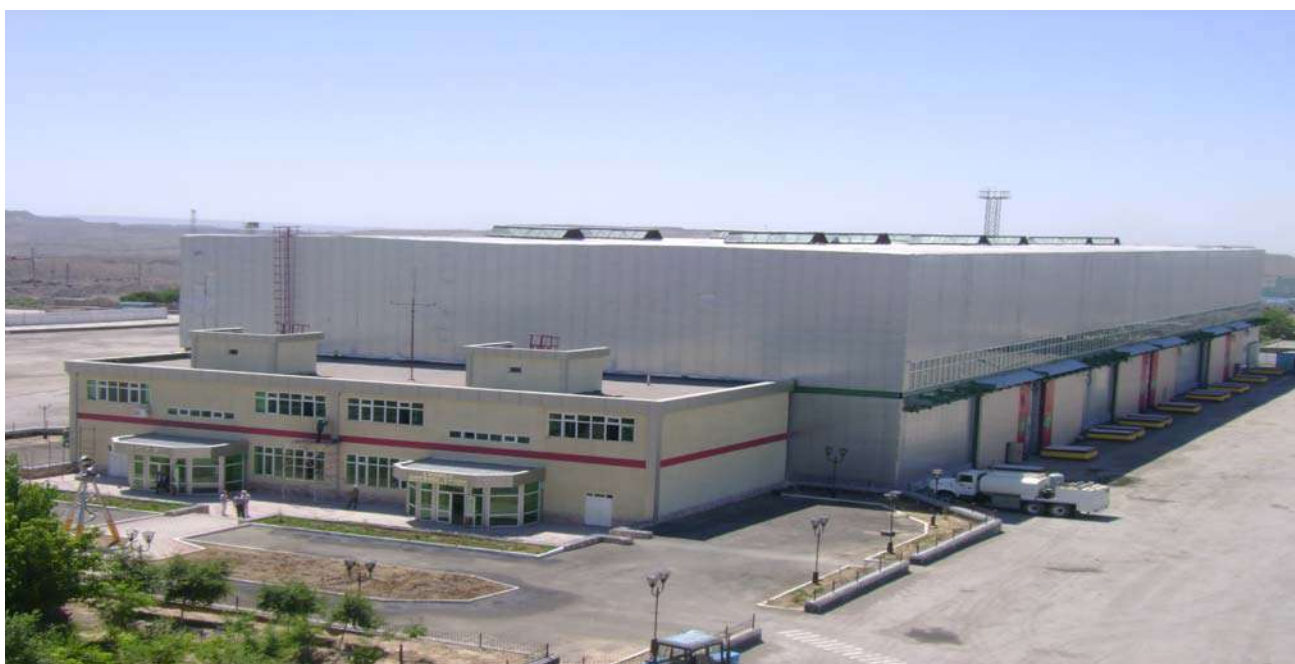
Цех ремонта технологического транспорта Управления Автотранспорта.
