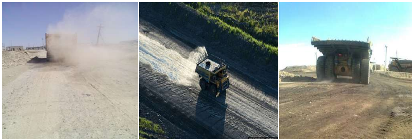
4-расм. Преперат сепилгаунга қадар (а) , преперат сепиш жараёни (б) ва преперат сепилгандан (в) кейинги жараёнлардан сўнг автомобил йўлининг кўриниши
