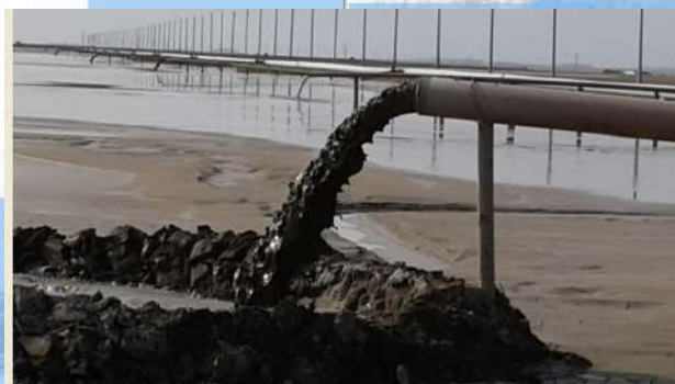
Рис.5. Намыв Разделительной дамбы веерным способом.
