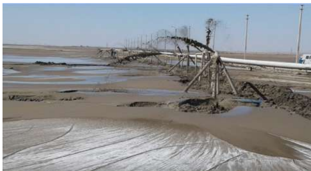
Рис.4. Намыв второго яруса Разделительной дамбы пульповыпуском ПВ-14л.
