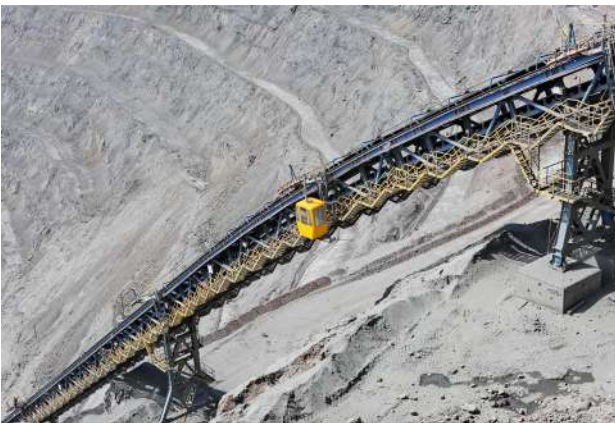
Рис. 2. Комплекс ЦПТ-руда, крутонаклонный конвейер.
