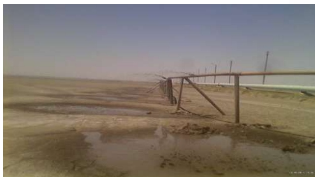
Рис.3. Начало намыва фронтальным способом пульповыпуском ПВ-14л.
