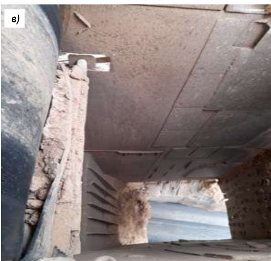
Рис. 2. Перегрузочный узел с конвейера № 3.7 на конвейер № 3.8: а) перегрузочный пункт № 3.7; б) внешний вид перегрузочного пункта; в) вид внутреннего приемного бункера
